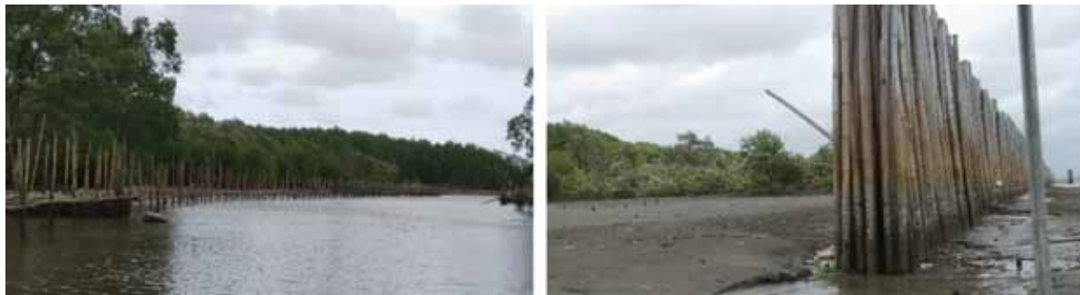
Obrázok 22: Nízkonákladové protizáplavové ochrany v Thajsku.
